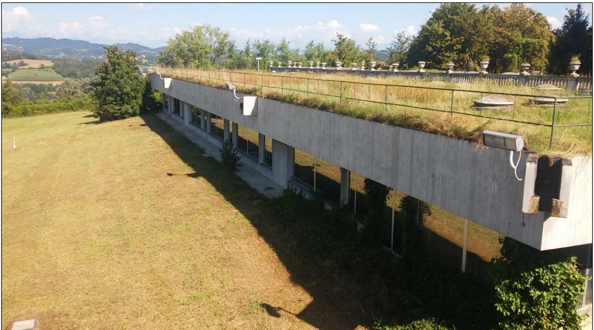
Il versante prativo lungo il lato Sud-Ovest del fabbricato principale
